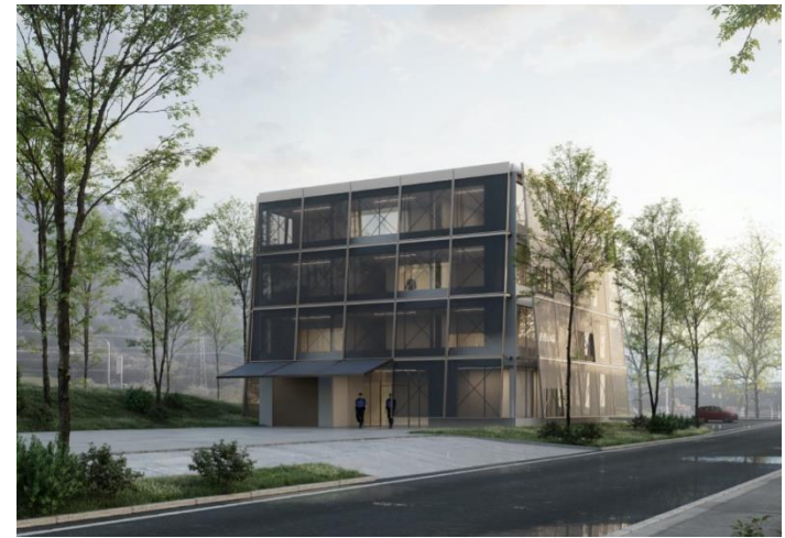
Quelle: Hochbauamt Graubünden / Verkehrsstützpunkt KAPO GR, Chur
